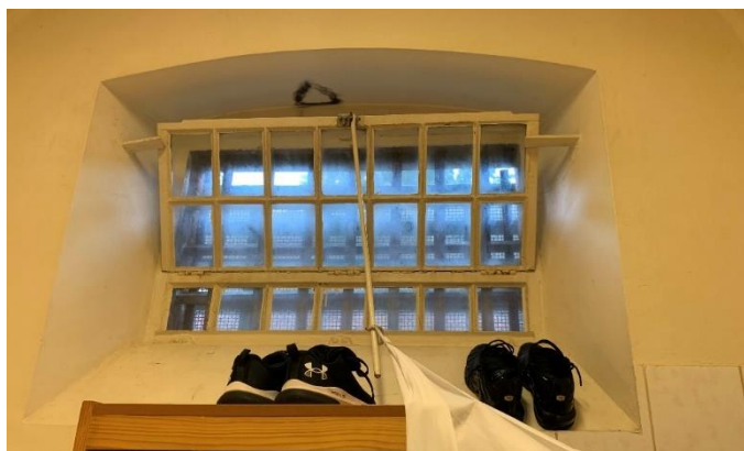
Les fenêtres de la cellule avec peu de lumière du jour
